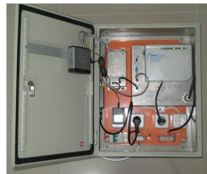
Рис. 6. Полевой пункт системы СССМ для наземной установки
