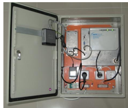
Рис. 6. Полевой пункт системы СССМ для наземной установки
